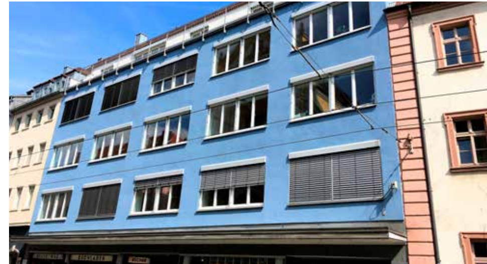
Buchladen „Neuer Weg“ Sanderstraße 23-25, Würzburg. Ausgeführt mit 16 cm Klimasan W und 8 mm eingefärbtem Klimasan Antik . Die Baumaßnahme wurde 2006 abgeschlossen. Foto vom Frühjahr 2018.
