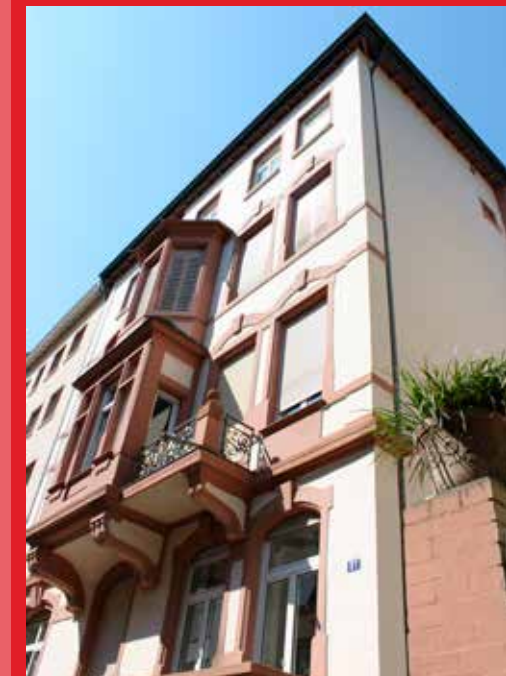
Städtisches Mietshaus in Frankfurt a.M., Wiesenau 51. Innendämmung mit Klimasan I .
