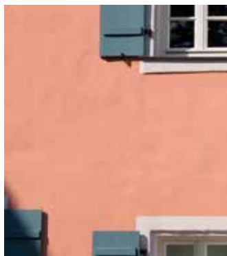
Alte Schleifmühle in Cadolzburg, Rütteldorf 1. Zweigeschossiger Walmdachbau mit Walmdachgauben und verputztem Sandsteinquaderbau um 1800. Klimasan W mit eingefärbtem Klimasan Antik .
